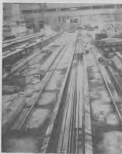
Рис. 1. Изготовление вибрированных опор ВЛ на длинном стенде
