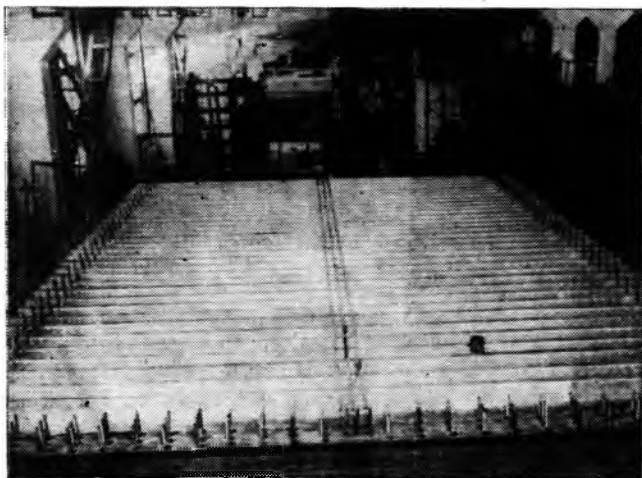
Рис. 2. Вид фрагмента перед бетонированием
