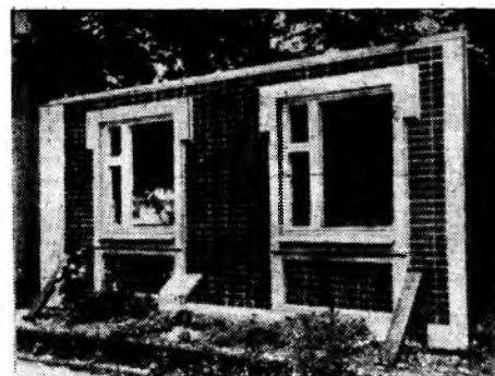
Рис. 2. Двухмодульная панель наружной стены дома серии П44/17
