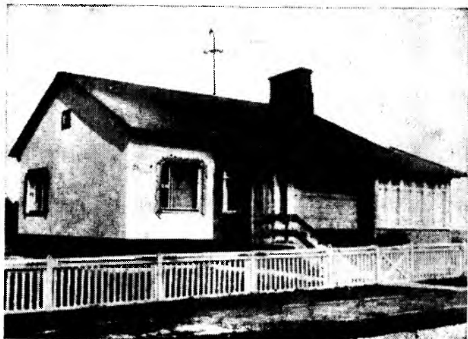
Рис. 4. Усадебный жилой дом из грунтобетона в Чуйской долине
