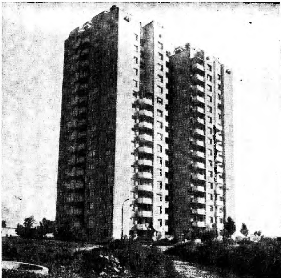
Рис. 2. 17-этажный жилой дом из монолитного железобетона в Кишиневе
