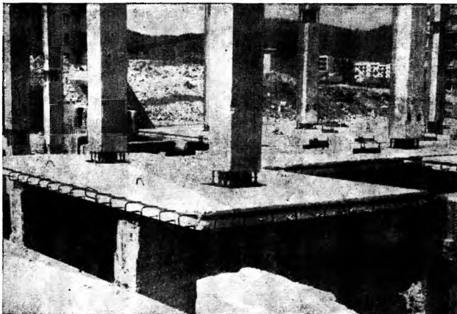
Рис. 3. Строительство жилых зданий с безбалочными перекрытиями в г. Эрденет
