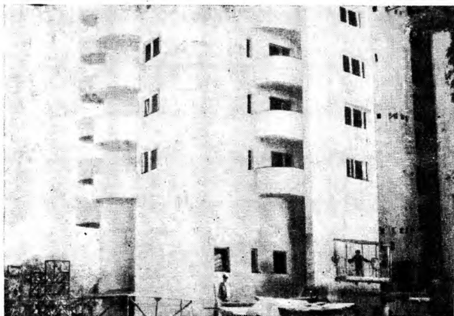
Рис. 2. Фрагмент наружной стены
