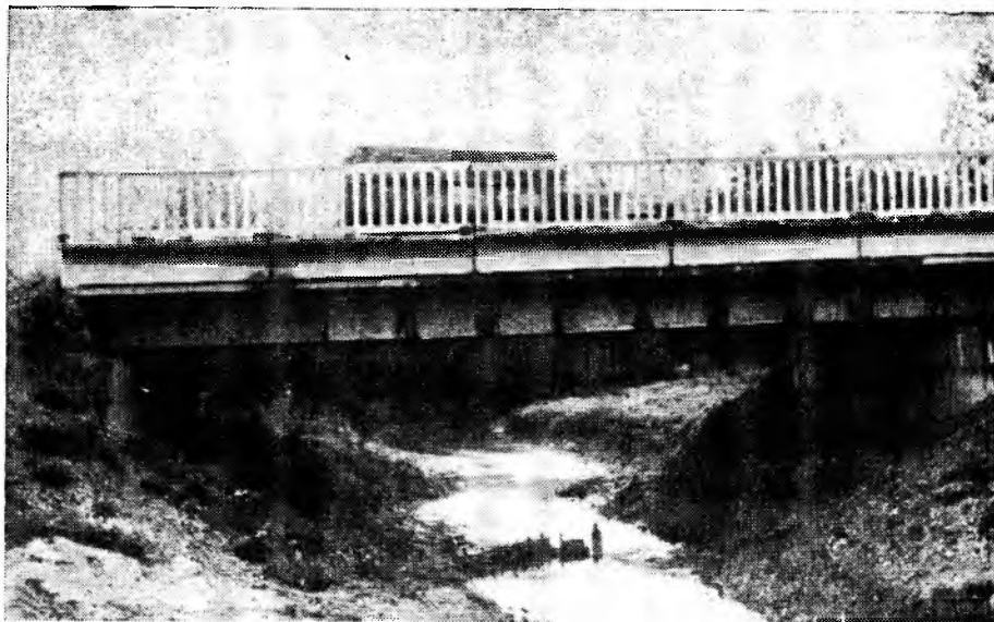
Рис. 2. Автодорожный мост с коробчатыми армоцементными балками
