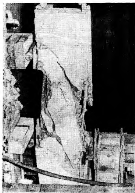
Рис. 1. Характер разрушения балки
