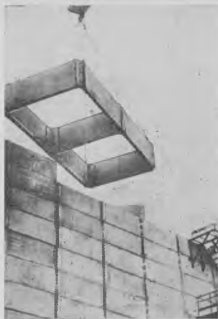
Рис. 2. Применение спаренных объемных блоков размером 3×6 м на монтаже элеватора в Скопине (Рязанской обл.)
