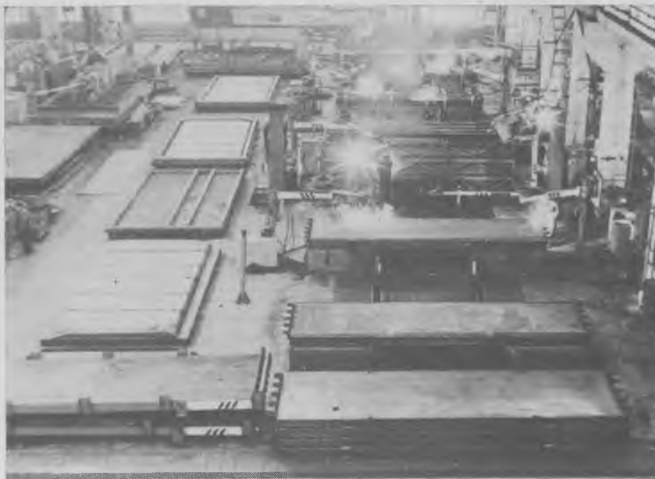
Рис. 2. Шаговый конвейер для изготовления поддонов с раскосной решеткой
