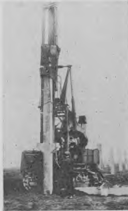
Рис. 1 Забивка свай-колонн
