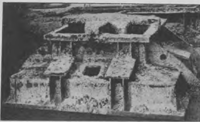
Рис. 2. Металлоформа ФК-17 с остатками бетона
