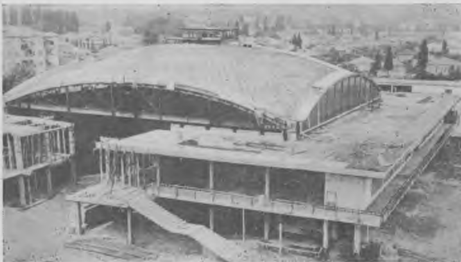
Рис. 1. Оболочка в процессе строительства
