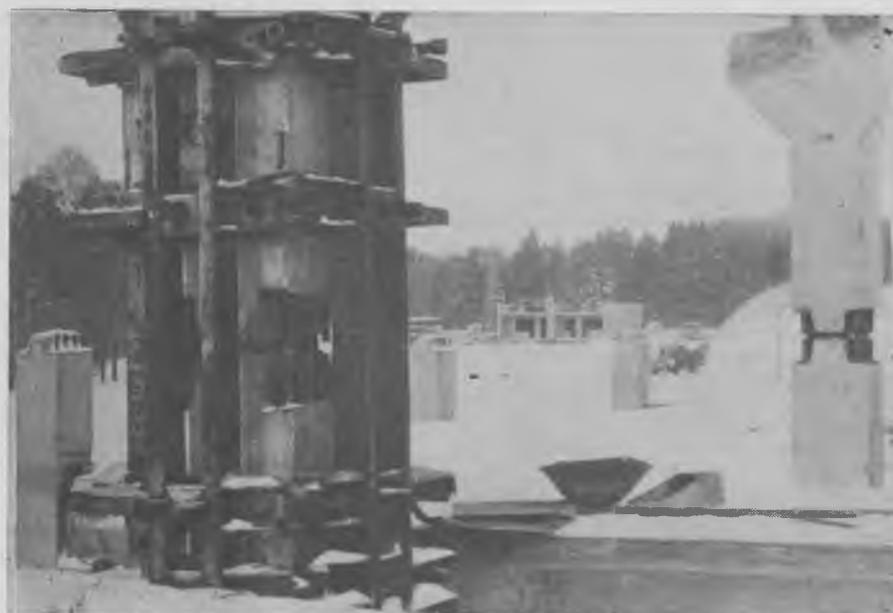
Рис. 2. Монтаж колонн с малометаллоемкими стыками каркаса серии ИИ-20 при строительстве здания в Московской области
