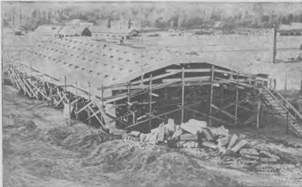
Рис. 1. Испытания призматической складки
