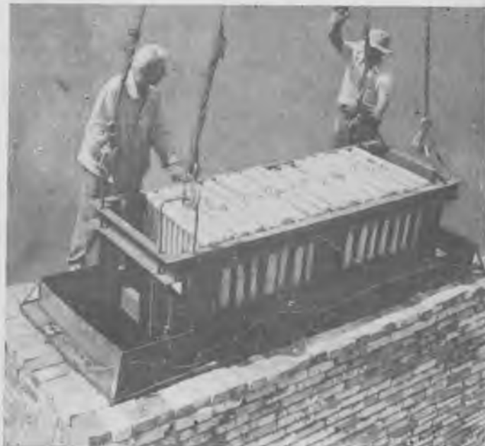
Рис. 1. Подготовка железобетонных стоек и решетчатых плит к пропитке
