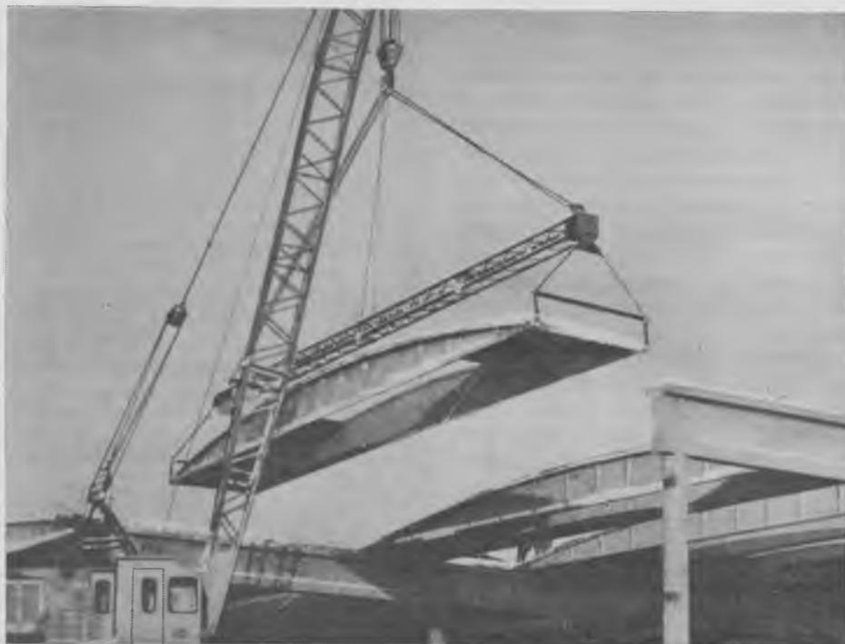
Монтаж панелей-оболочек КЖС размером 3×24 м и центрифугированных колонн кольцевого сечения при строительстве промышленного здания
