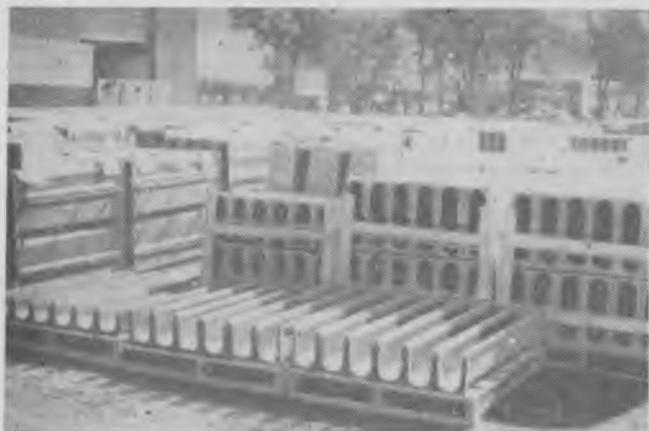
Рис. 2. Большие элементы из полимербетона на основе полиэфирной смолы для отделки фасадов домов
