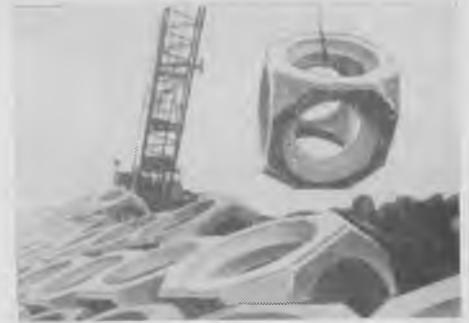
диаметром 700 мм. Эта опалубка в виде резинового шара в чехле из брезента закачивалась воздухом до давления 0,28 кг/см<sup>2</sup>, причем ее положение фиксировалось прижимом к выступающим ребрам боковых отверстий формы. Оставшееся между стенками формы и шаром пространство через верхнее отверстие заполнялось бетоном и уплотнялось глубинным вибратором. Бетонная смесь включала в себя добавку золы-уноса, что позволило экономить до 25% цемента за счет снижения водоцементного отношения.
