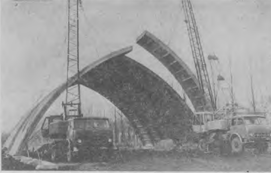
Монтаж двумя кранами технического обменного пункта «Сельхозтехники» в г. Брусилове (Житомирская обл.). Сводчатое здание из ребристых панелей-оболочек одинарной кривизны
