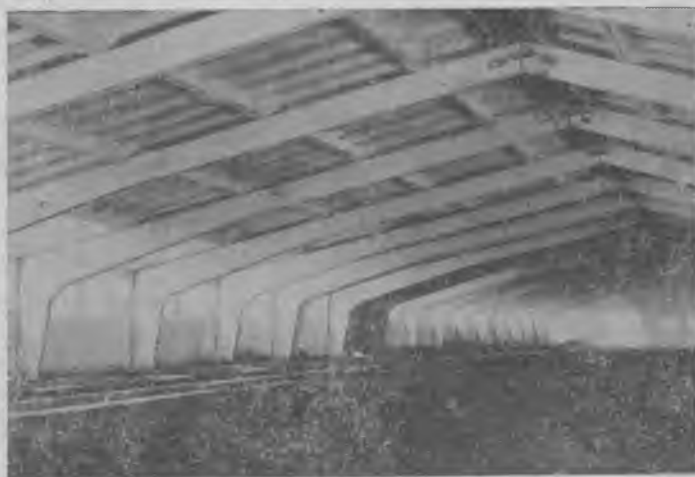
Рис. 2. Здание коровника с каркасом из трехшарнирных рам в пос. Пески Сумской обл.
