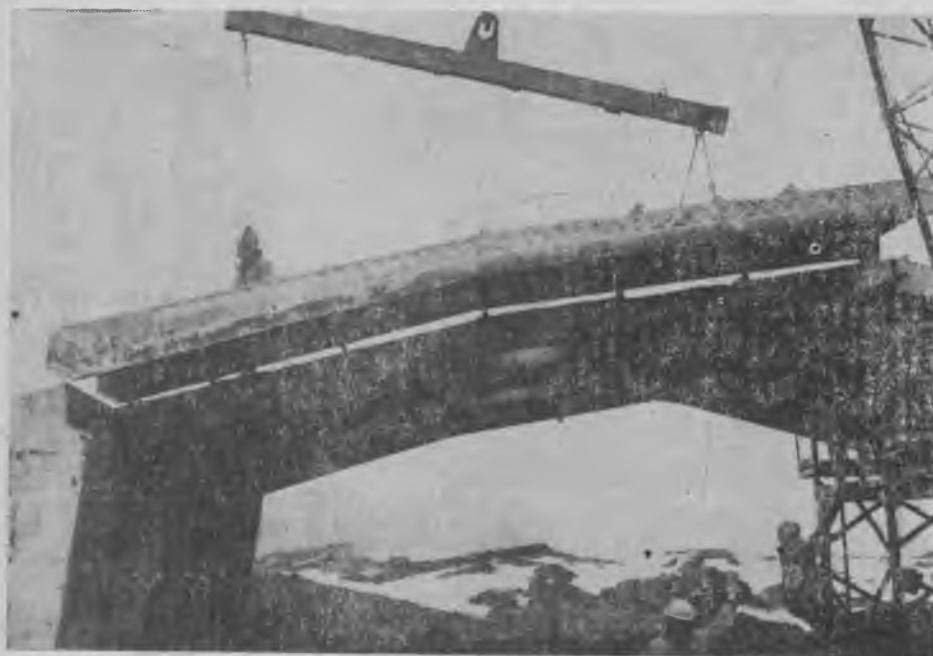
Рис. 3. Монтаж железобетонных складчатых рамно-панельных конструкций
