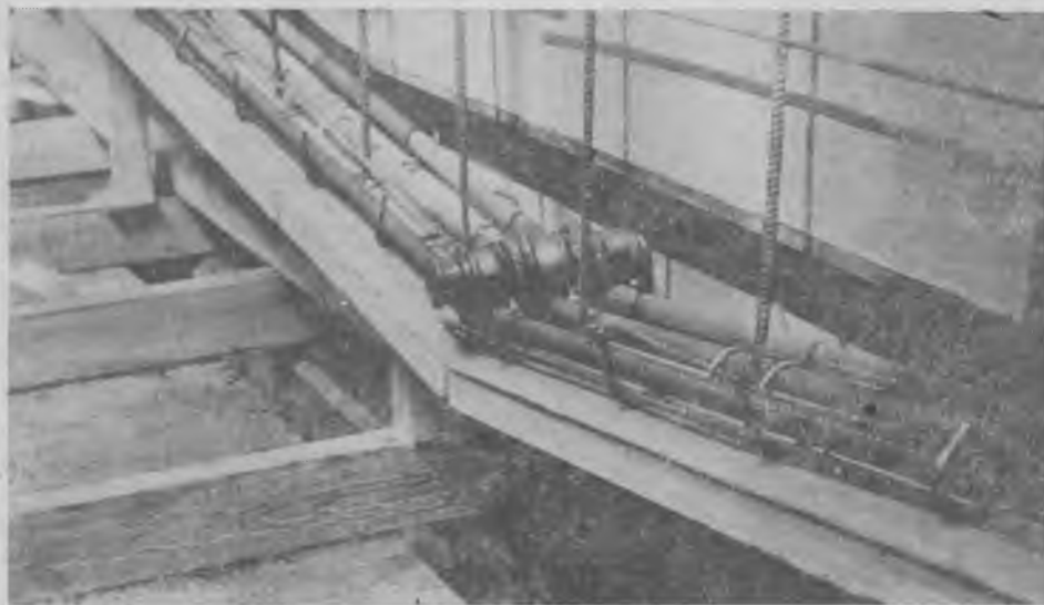
Рис. 2. Приспособление для оттяжки арматуры
