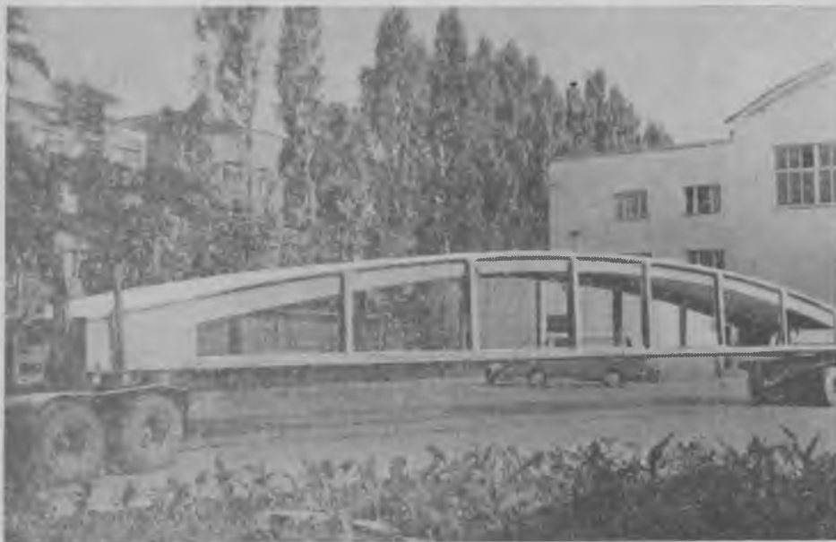
Панель-оболочка коммуникационного типа размером 3×24 м, массой 14 т
