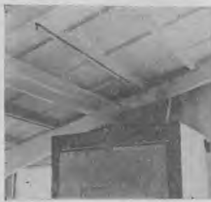
Рис. 1. Покрытие унифицированного коровника из преднапряженных ребристых плит серии 1.865-1
