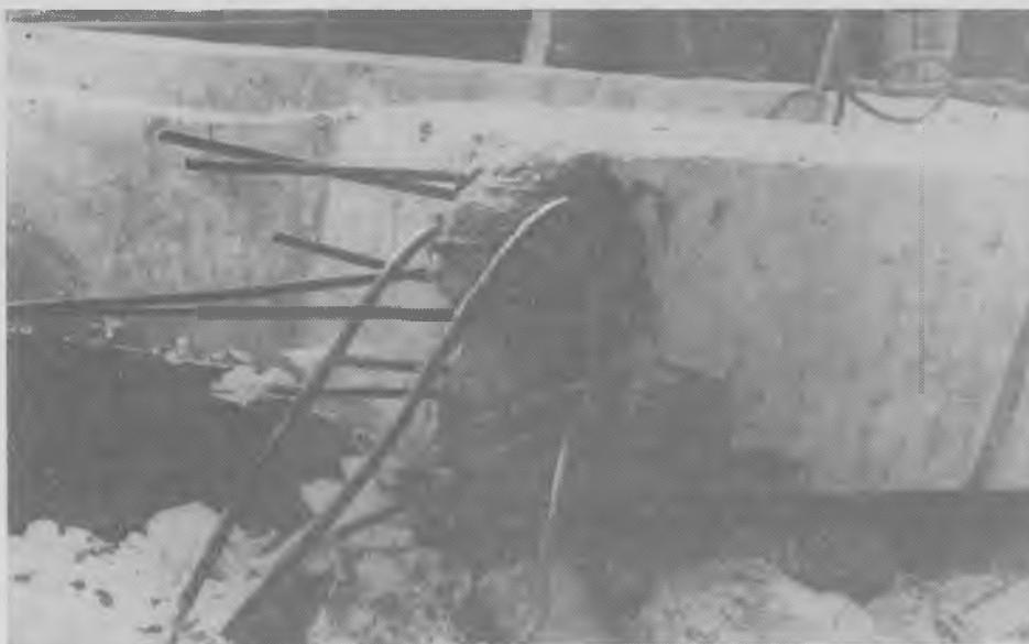
Рис. 1. Характер разрушения арматуры в нижнем поясе подстропильной фермы
