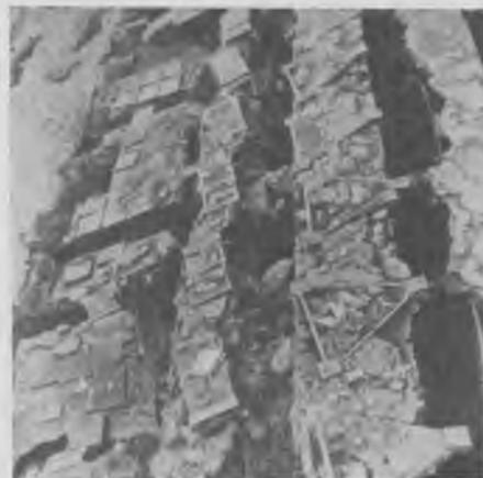
Рис. 3. Общий вид разрушенных железобетонных плит
