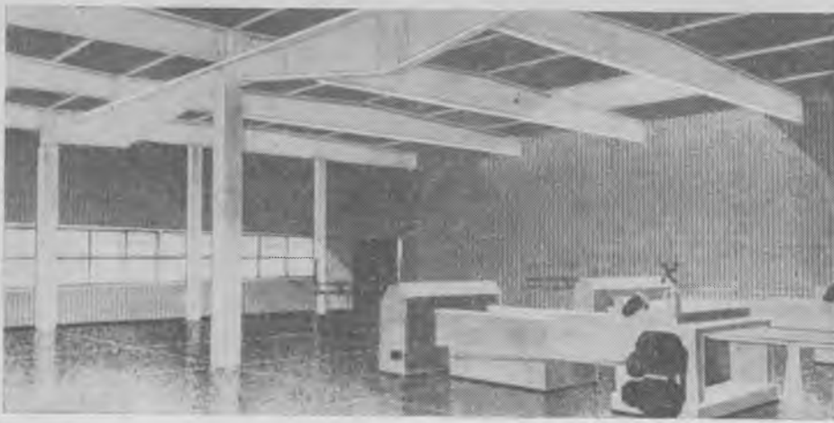
Рис. 1. Главный корпус Азовского промкомплекса по производству консервов детского питания
