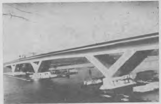
Рис. 6. Железобетонный мост с неразрезным составным по длине пролетным строением величиной 150 м
