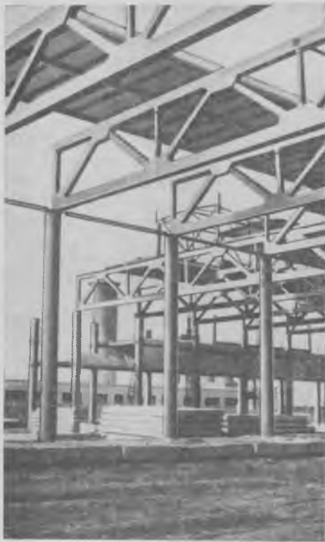
Рис. 1. Строительство одноэтажного промздания с центрифугированными колоннами кольцевого сечения из бетона марки М600
