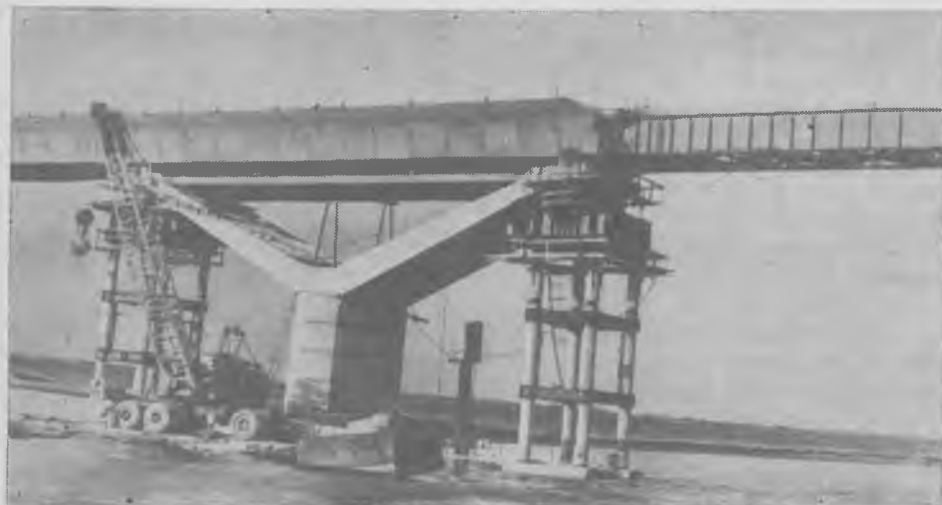
Рис. 3. Продольная навodka неразрезного пролетного строения длиной до 63 м из коробчатых блоков постоянной высоты, объединяемых клееными стыками
