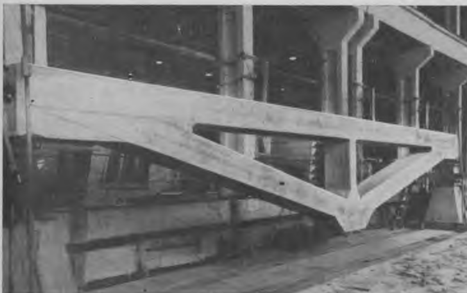
Рис. 2. Общий вид фермы перед испытанием
