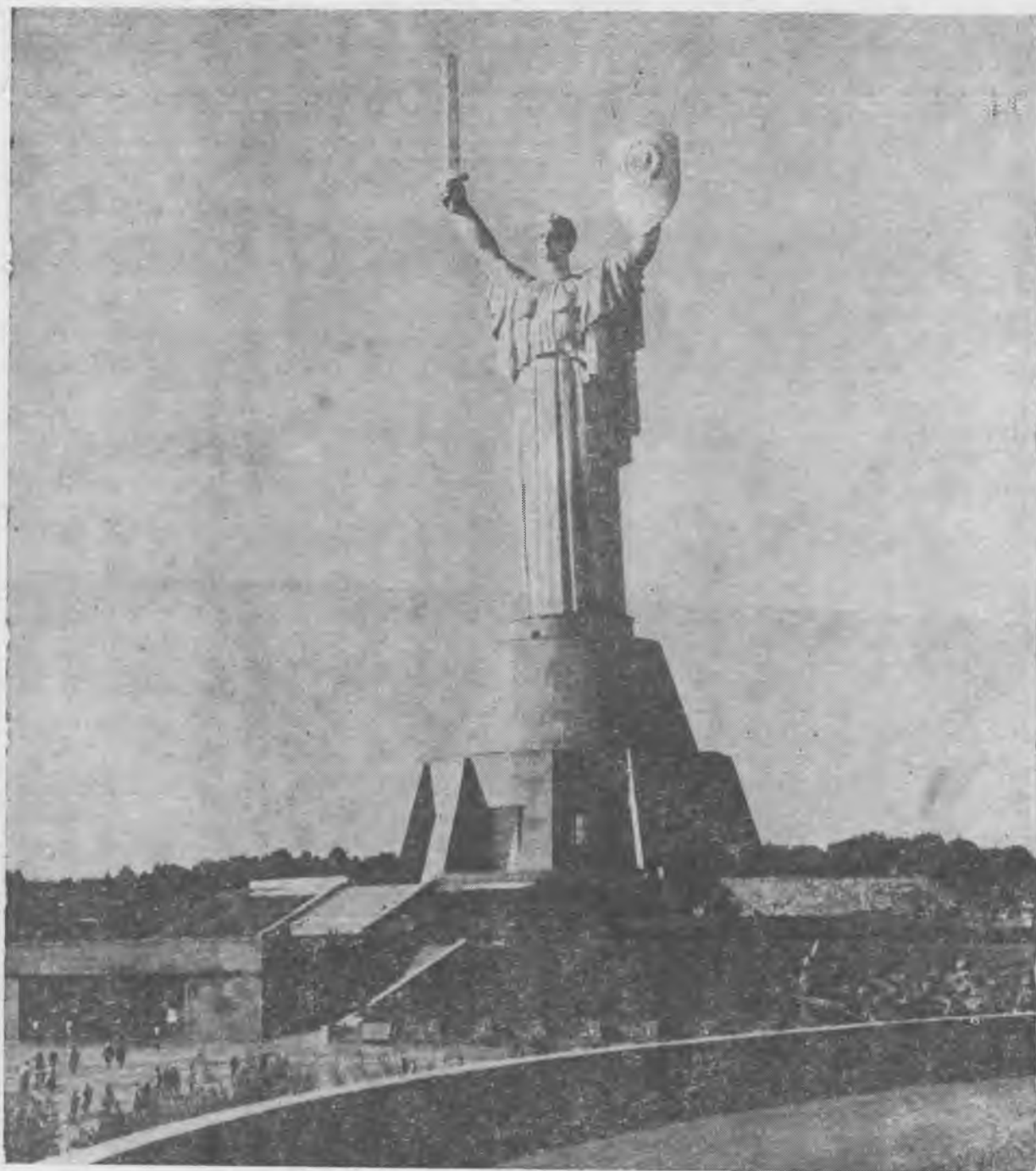
Общий вид здания музея истории Великой Отечественной войны в Киеве (к статье А. И. Буракаса «Эффективные преднапряженные и обычные железобетонные конструкции зданий»)
