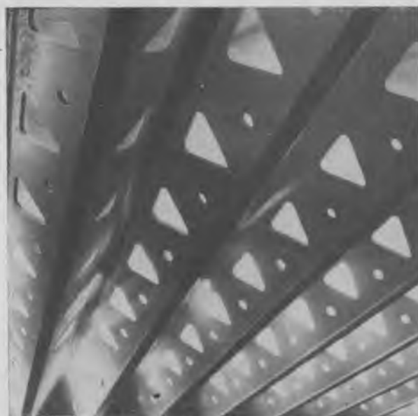
Рис. 2. Коробчатые настилы треугольного очертания в перекрытии зрительного зала Дома художников в Киеве
