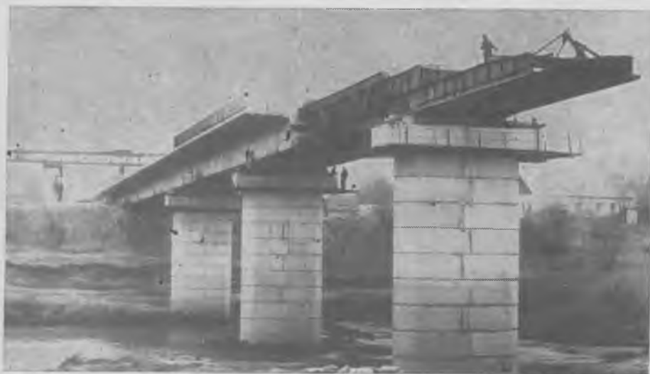
Рис. 2. Продольная навodka моста с неразрезным пролетным строением из блоков ПРК-ЦНИИС
