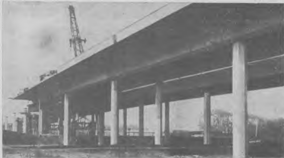
Рис. 1. Сборка неразрезных пролетных строений системы ПРК-ЦНИИС путепровода в Ленинграде
