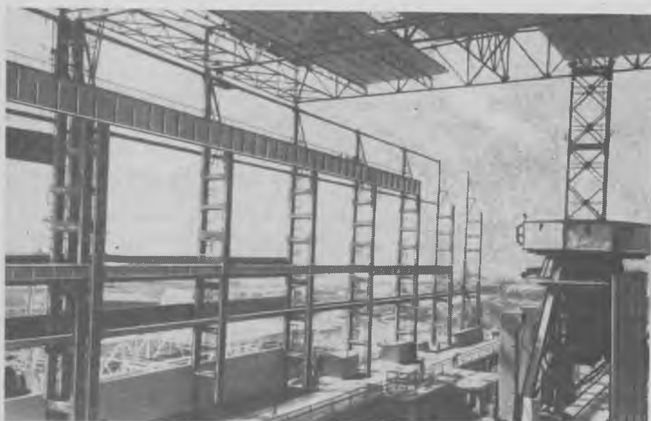
Рис. 2. Главный корпус ТЭЦ с двухветвевыми колоннами с внешним армированием из бетона марки М600
