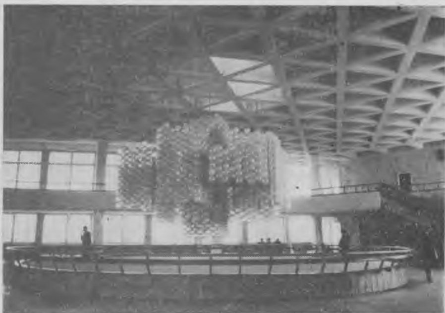
Рис. 4. Перекрытие здания автовокзала во Львове (интерьер)
