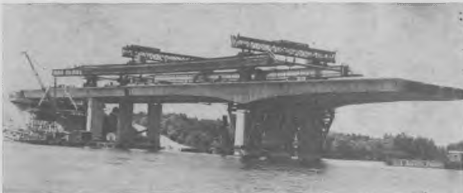
Рис. 5. Уравновешенная навесная сборка неразрезных пролетных строений моста через р. Днепр
