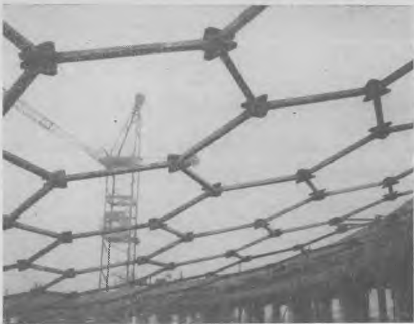
Рис. 6. Вантовая сеть покрытия бьюета минеральных вод в Трускавце
