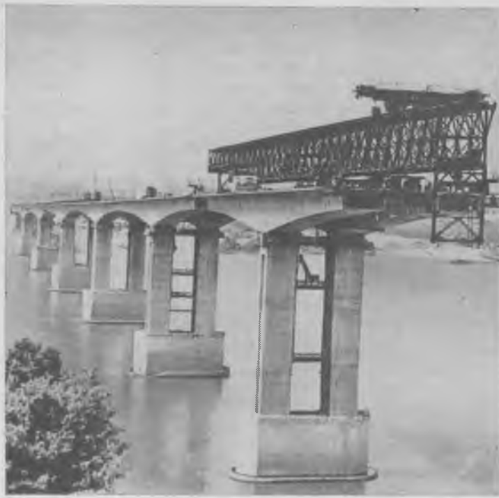
Рис. 4. Уравновешенная навесная сборка неразрезных преднапряженных пролетных строений величиной до 128 м краном КМ-128/65
