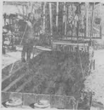
Кассетная форма для изготовления преднапряженного бортового камня
