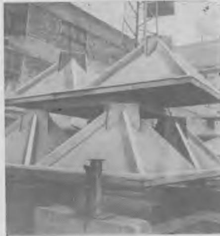
Рис. 3. Армоцементные пирамидальные конструкции перекрытий
