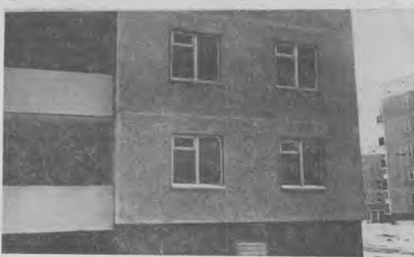
Рис. 2. Фрагмент фасада дома серии III-108, отделанного цементно-песчаными гранулами
