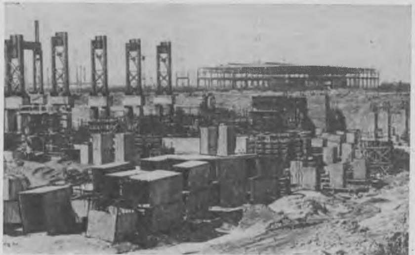
Рис. 2. Общий вид места складирования армоблоков в котловане (справа видны смонтированные армоблоки)
