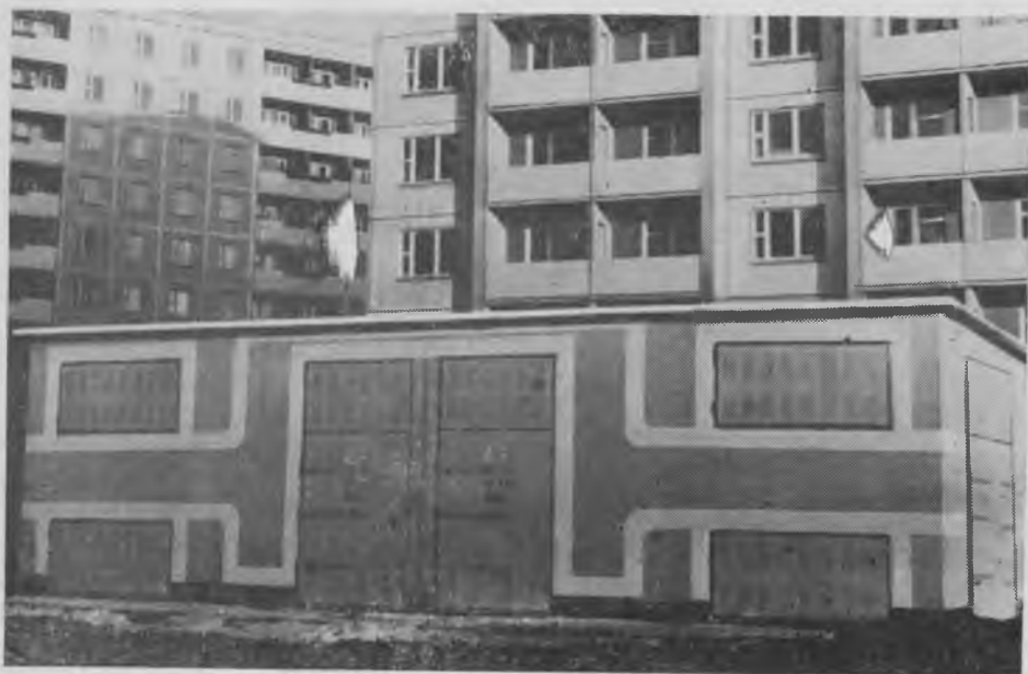
Рис. 4. Трансформаторная подстанция из объемных блоков в Киеве
