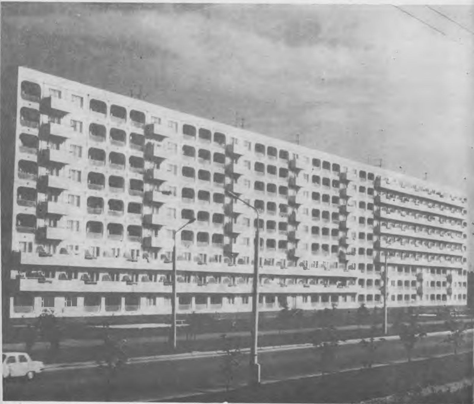
Жилой дом галерейного типа для малосемейных в Минске (к статье А. Е. Козел, Д. А. Михайловского, Г. И. Станчика «Опыт объемно-блочного домостроения в Минске»)
