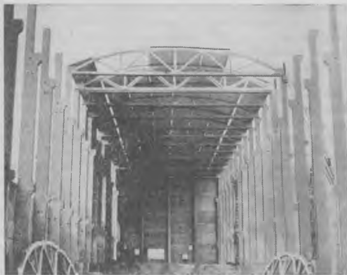
Рис. 2. Фермы-диафрагмы складчатого покрытия пролетом 24 м (Броварский завод ЖБК, Киев)
