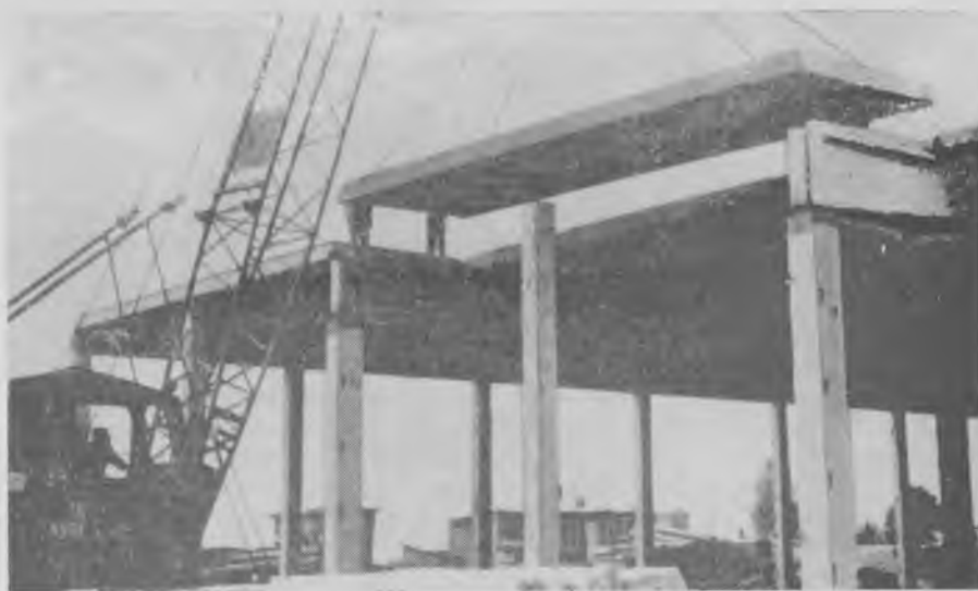
Рис. 2. Экспериментальное строительство одноэтажного промышленного здания с неразрезными сборно-монокричными балками и плитами покрытия с преднапряженными стыками
