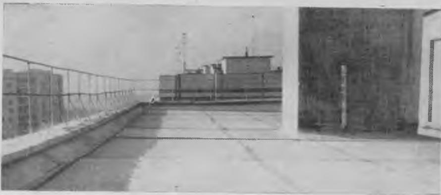
Рис. 3. Общий вид крыши с безрулонной кровлей и «теплым» чердаком
