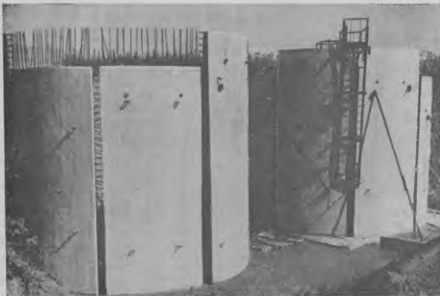
Рис. 1. Отстойники диаметром 9 м, высотой 9 м
