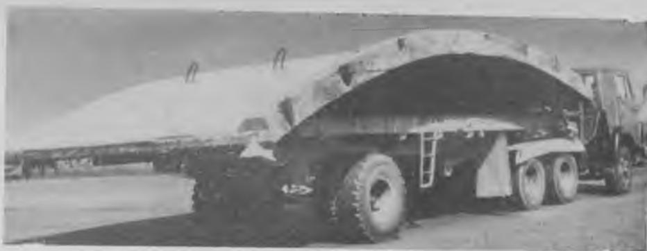
Рис. 4. Отстойник диаметром 24 м, высотой 3,9 м. Транспортировка стеновых панелей площадью 36 м<sup>2</sup>
