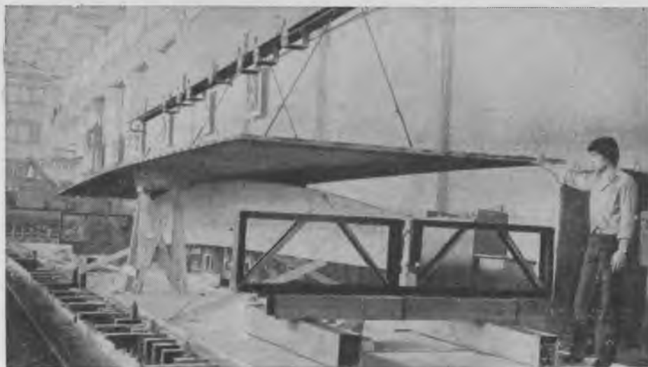
Рис. 3. Процесс монтажа плиты и ребра панели
