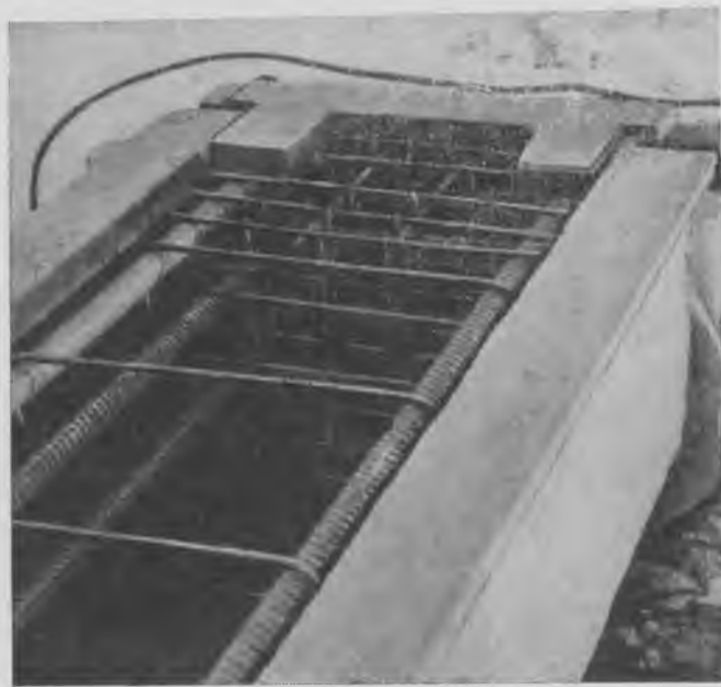
Рис. 3. Подготовленная к бетонированию форма с арматурным каркасом колонны с выпусками арматуры
