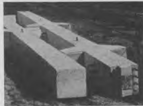
Рис. 4. Колонны с выпусками арматуры, изготовленные на Клиском комбинате Стройиндустрия
