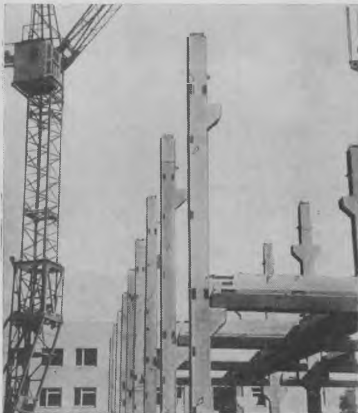
Рис. 3. Подготовленная к бетонированию форма с арматурным каркасом колонны с выпусками арматуры
