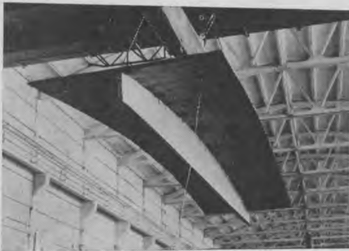
Рис. 1. Панель покрытия из тонких преднапряженных пластин
