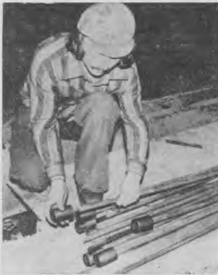
Рис. 2. Соединение зажимов с арматурой и укладка ее в упоры
