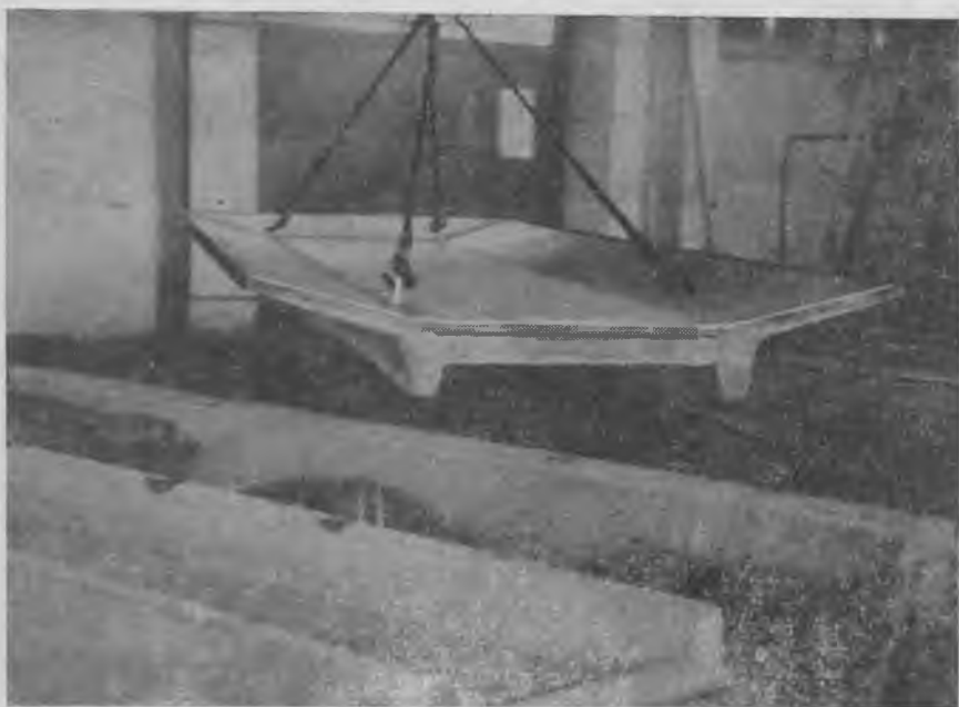
Рёбристая кровельная панель, изготовленная из напрягающего бетона
