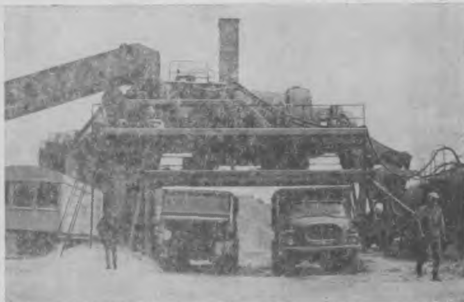
Рис. 4. Автоматизированная бетоносмесительная установка непрерывного действия СБ-109
