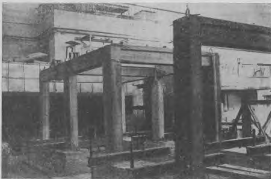
Рис. 1. Фрагмент пространственного сборно-монолитного фундамента в процессе испытаний
