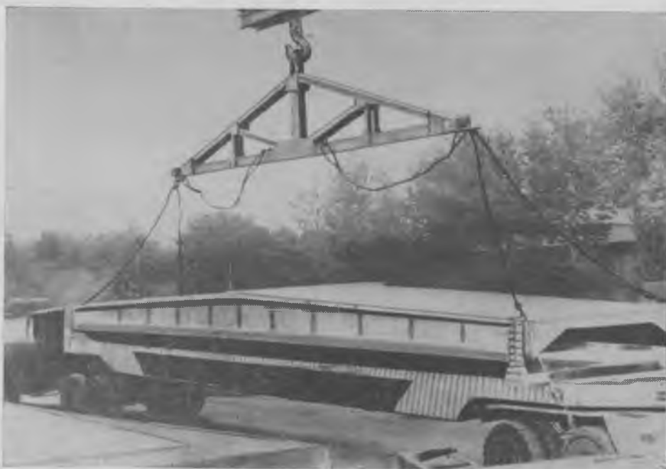
Рис. 2. Плита типа «П» размером 3×18 м
