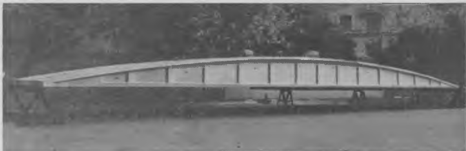
Рис. 1. Панель-оболочка КЖС из аглопоритобетона размером 3×24 м
