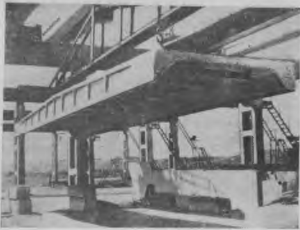
Рис. 1. Общий вид плиты покрытия размером 3×18 м из керамзитобетона
