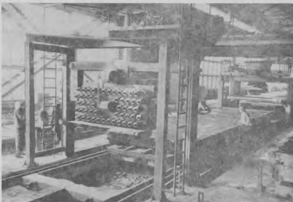
Рис. 2. Формовочный пост двухъярусного стана
