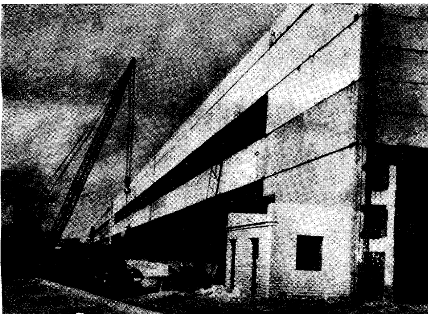
Рис. 3. Производственный корпус Днепропетровского трубопрокатного завода
