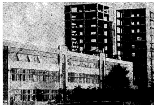
Рис. 2. Инженерный корпус объединения «Автодизель» с плитами перекрытий из шунгизитобетона
