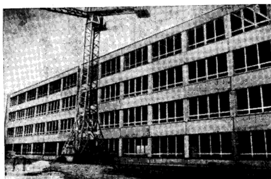
Рис. 1. Здание с несущими конструкциями из шунгизитобетона в Ярославле
