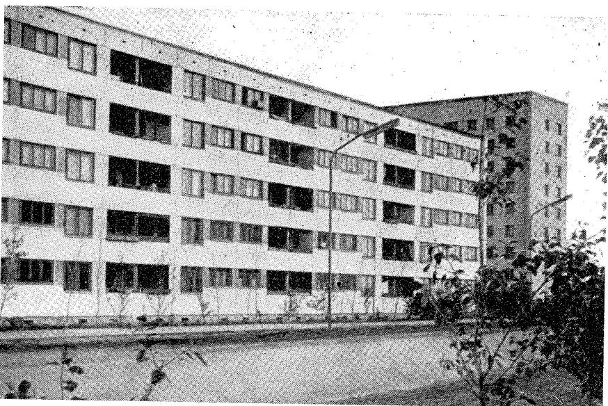
Крупнопанельный жилой дом серии I-468АЯ с несущими и ограждающими конструкциями из ячеистого бетона объемной массой 700 кг/м<sup>3</sup> в Павлодаре
