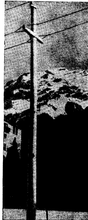
Рис. 1. Центрифугированная железобетонная опора для ЛЭП в горном районе
