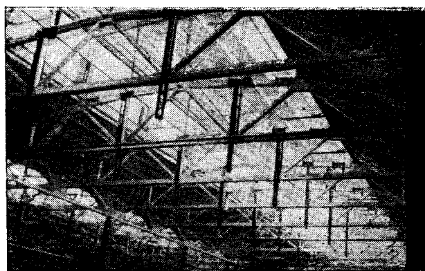
Рис. 4. Блок цехов БелАЗа (в покрытии установлены стропильные аглопоритобетонные фермы пролетом 24 м)
