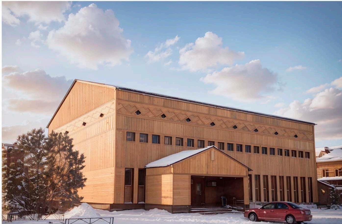
С момента постройки и примерно до 2000-х фасад здания отражал традиционность и дух севера с помощью выложенных орнаментов на стене. Наша идея вернуть тот же образ, но более современно. Фасад выполнен из вертикальных и горизонтальных реек. На третьем этаже рейки складываются в воздушный орнамент чум, в который врезается существующий витраж. Здание по углам выделяется упрощенными пилястрами. Цоколь остается подчеркнутым.
