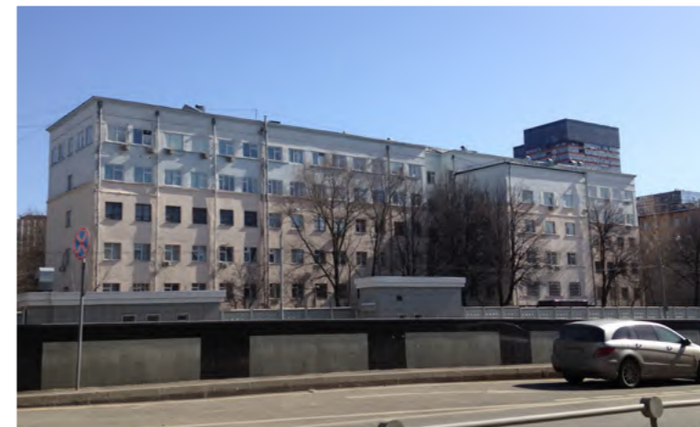
вид с улицы Балтийская
