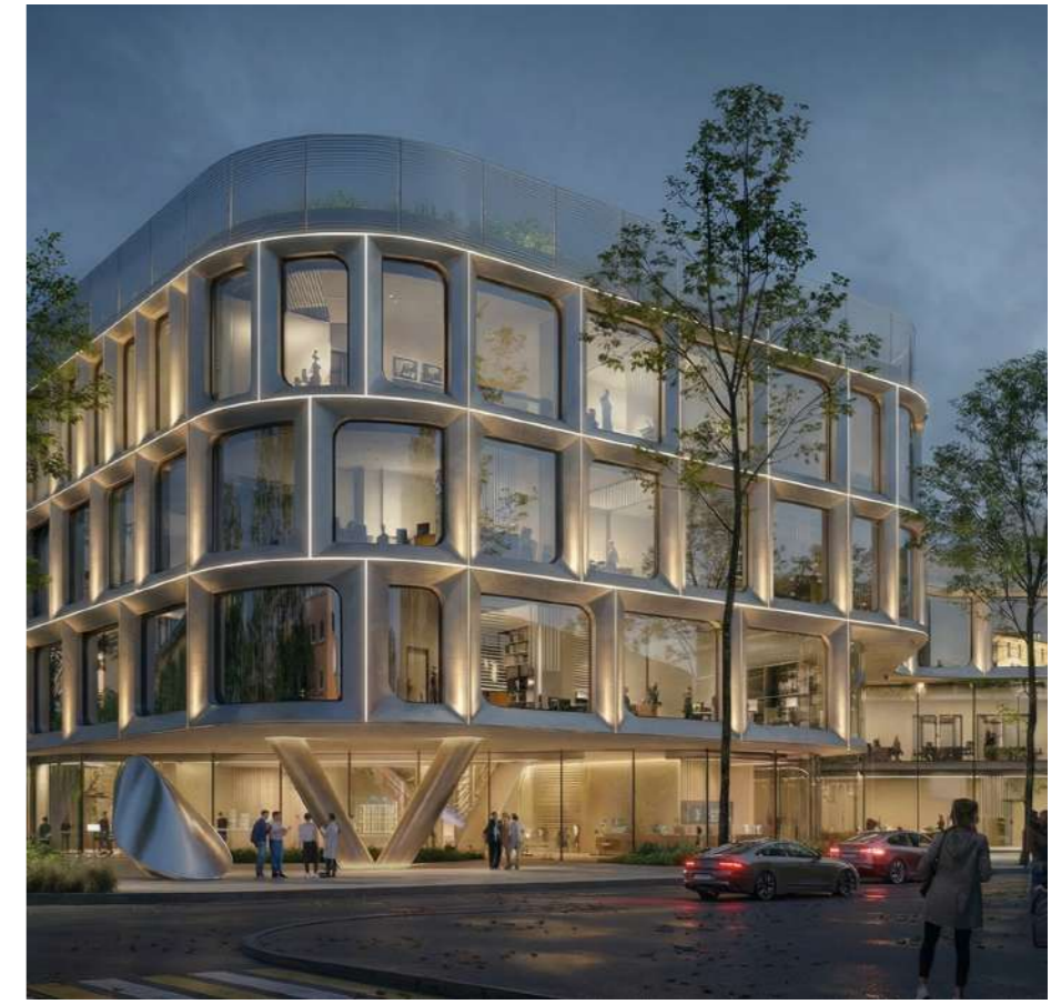
Светодиодное освещение ленточного типа интегрированное в металлические кассеты
