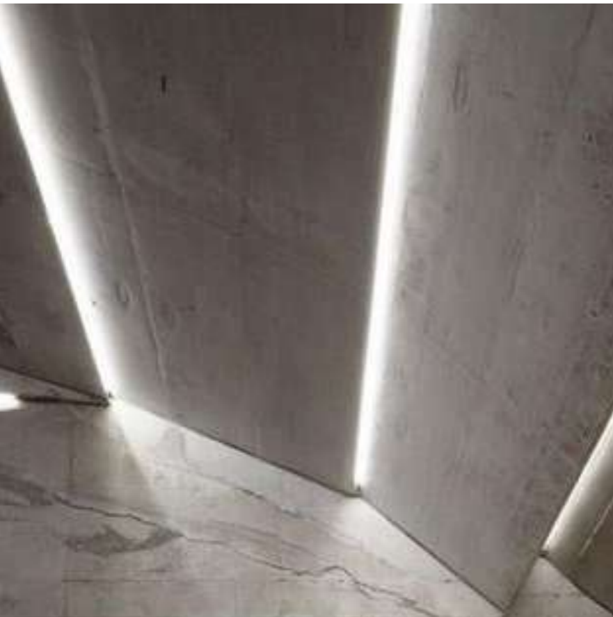
Визуальный дизайн подчинен акустике. Крупные элементы отделки стен выполняют роль акустических диффузоров или поглотителей
