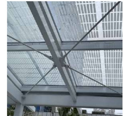
Белые металлические конструкции навесов
