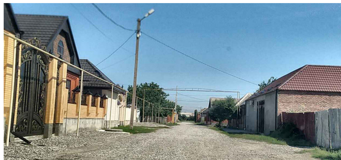
1-Й ЭНГЕНОВСКИЙ ПЕР. ОТСУТСТВИЕ ТВЁРДОГО ПОКРЫТИЯ ПРОЕЗЖЕЙ ЧАСТИ
