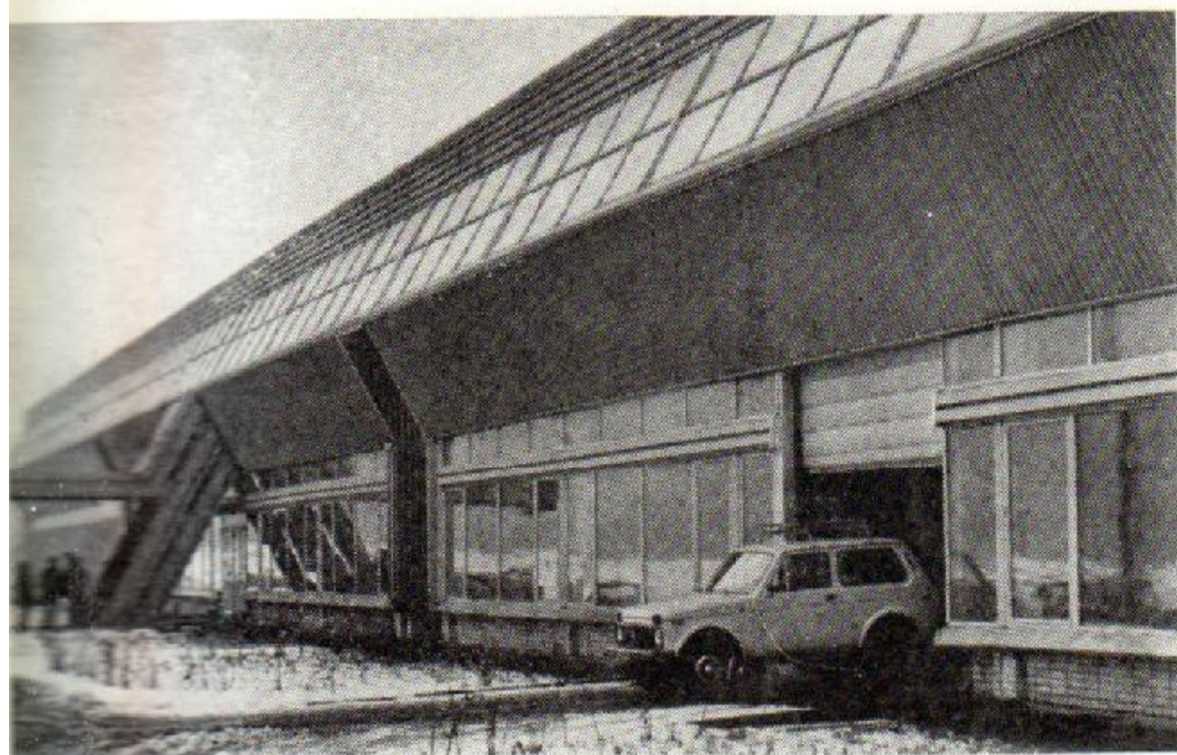
Строительство унифицированного здания (модуля) по типовому проекту 400-0-21.83
