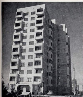
12-этажный жилой дом в Кrasnodаре
