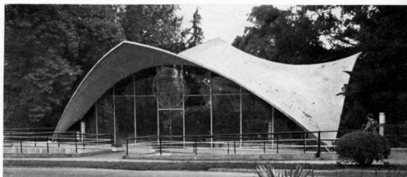
Ресторан в Паланге (Литовская ССР). Железобетонная грибовидная оболочка Автор — архитектор А. Ейгирдае
