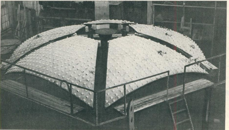
опиралось на пять контрфорсов, переходящих в фундаменты; основание принималось без свай. По периметру конструкция снабжена затяжками.
