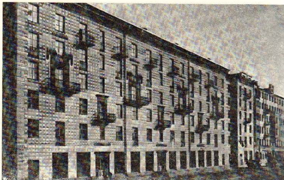
Жилой дом из крупных блоков на Большой Полянке в Москве. Общий вид. Совместно с архитектором Б. Блохиным. 1939 г.
