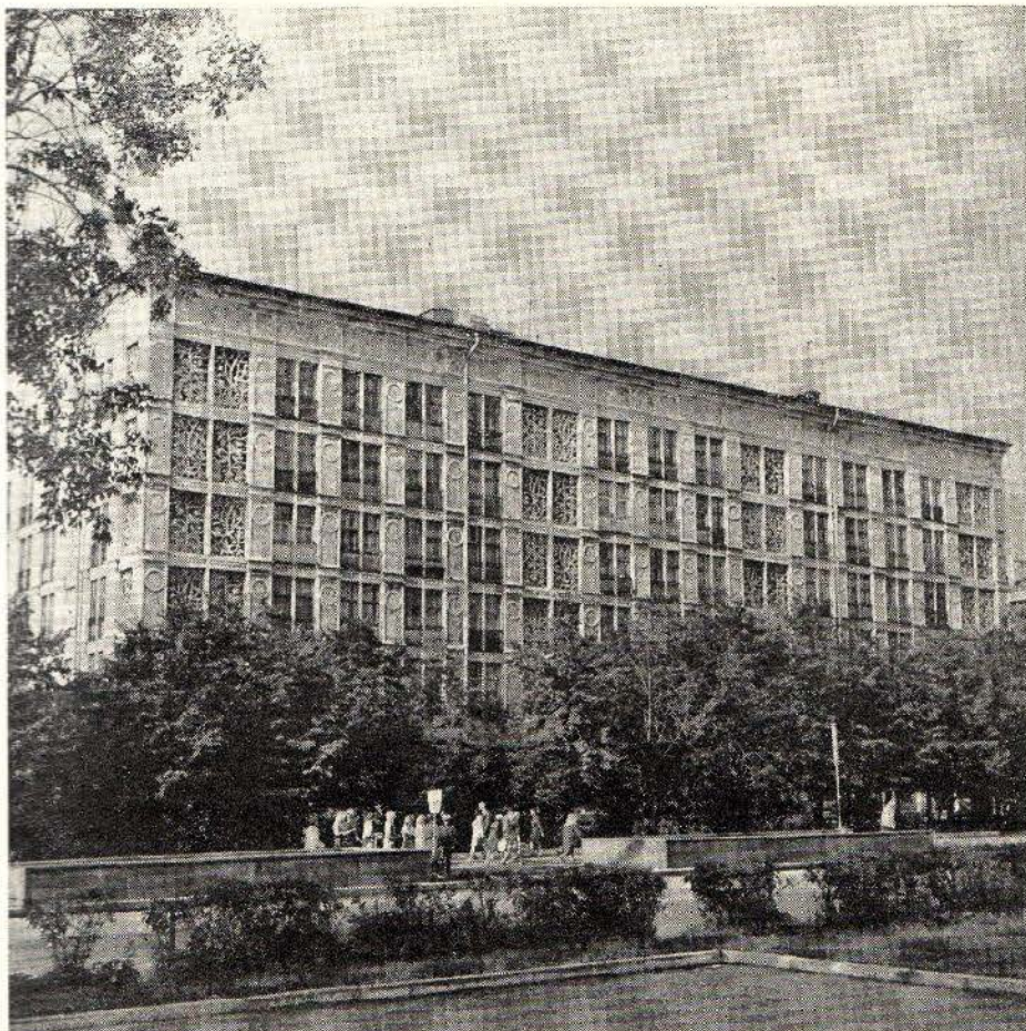
Жилой дом из крупных блоков на Ленинградском проспекте в Москве. Общий вид. План Совместно с архитектором Б. Блохиным. 1940 г.
