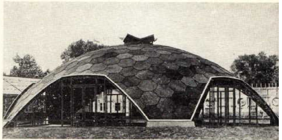
Рис. 2а. Павильон для спортивных игр. Пионерский лагерь «Березка» близ г. Кикрова, 1976 г. Сетевая разбивка купола в ориентации № 1
