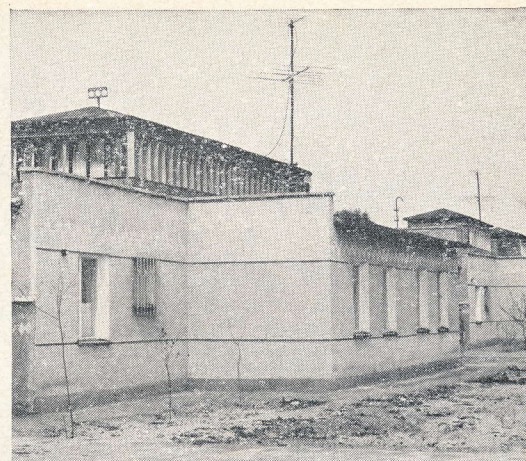
Поселок колхоза «Октябрь» Самаркандской области. Жилой дом с «шипангом» [для вертикального проветривания]
