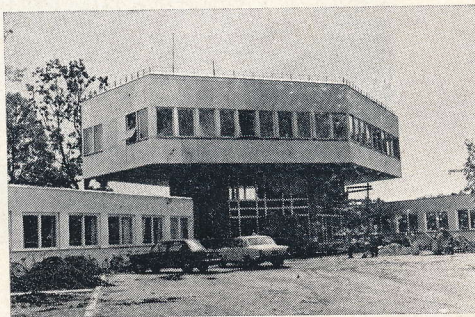
Административный корпус производственного комплекса для откорма 39 тыс. свиней в год в совхозе «Огре». Архитектор З. Абелите, инженер Велкерс
