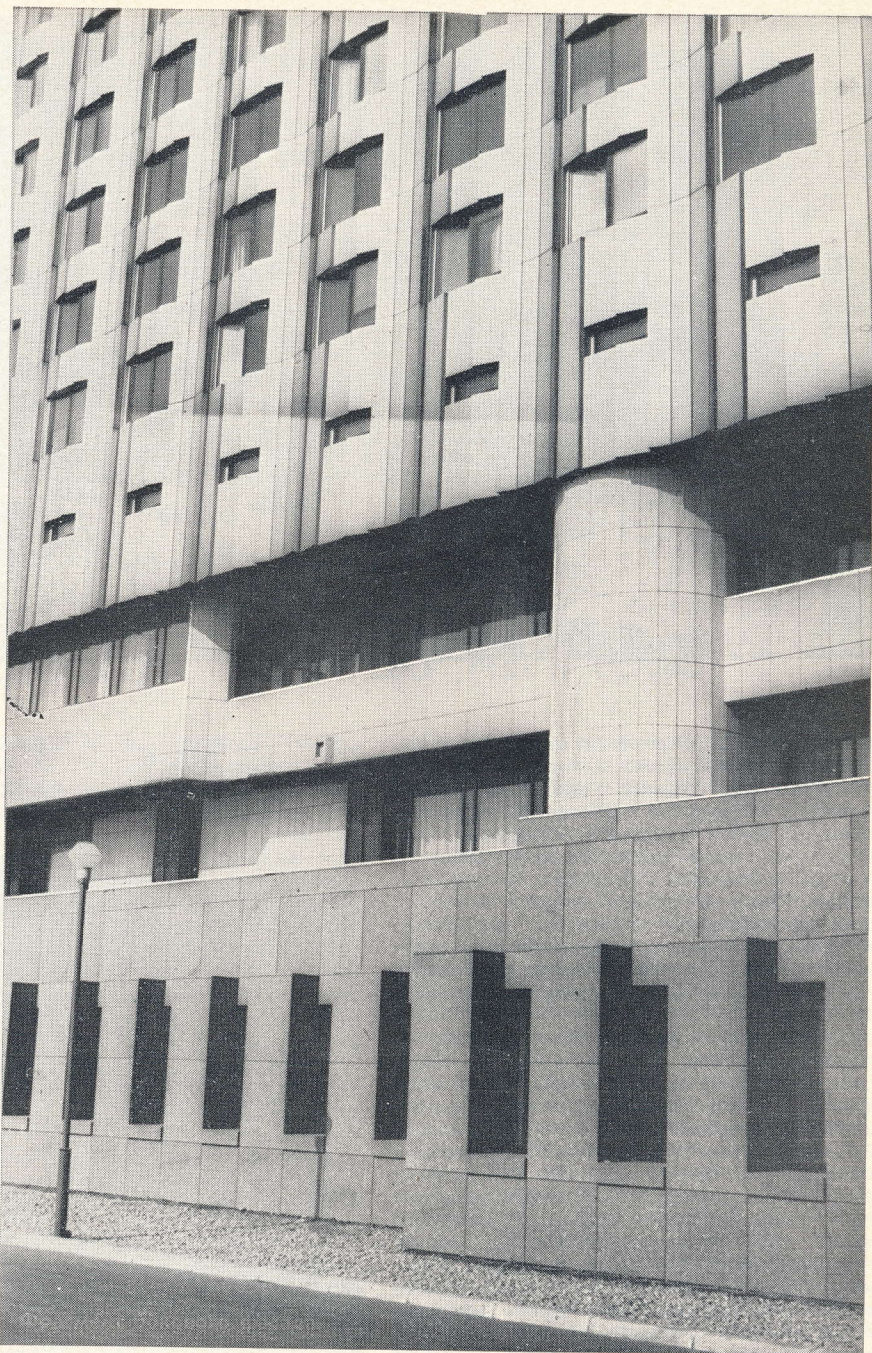
Фрагмент бокового фасада
