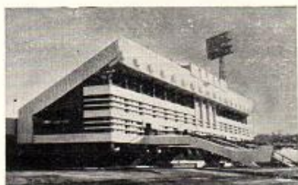
А. Попов [в коллективе]. Реконструкция стадиона «Химики» в Кемерове
