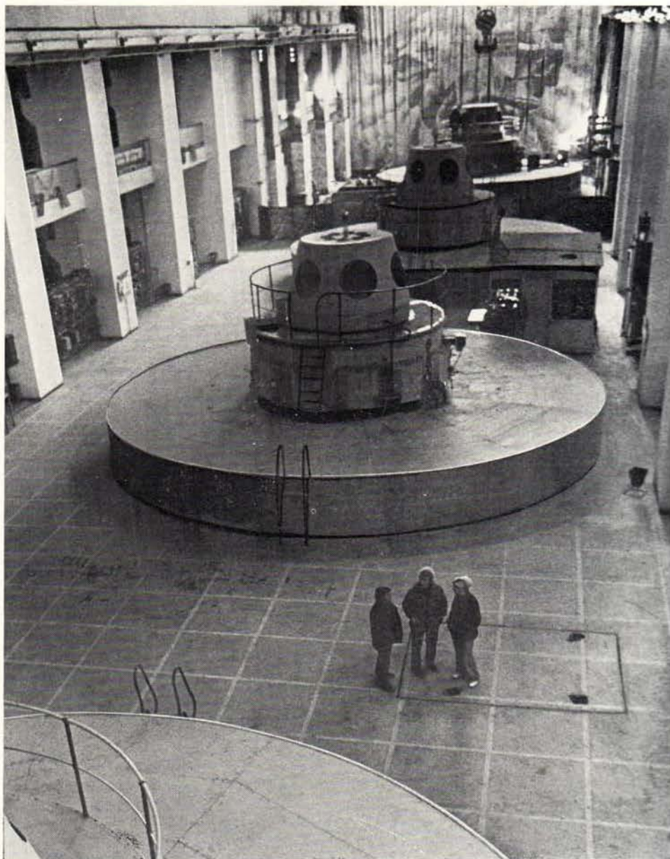
Нурекская ГЭС. Машинный зал
