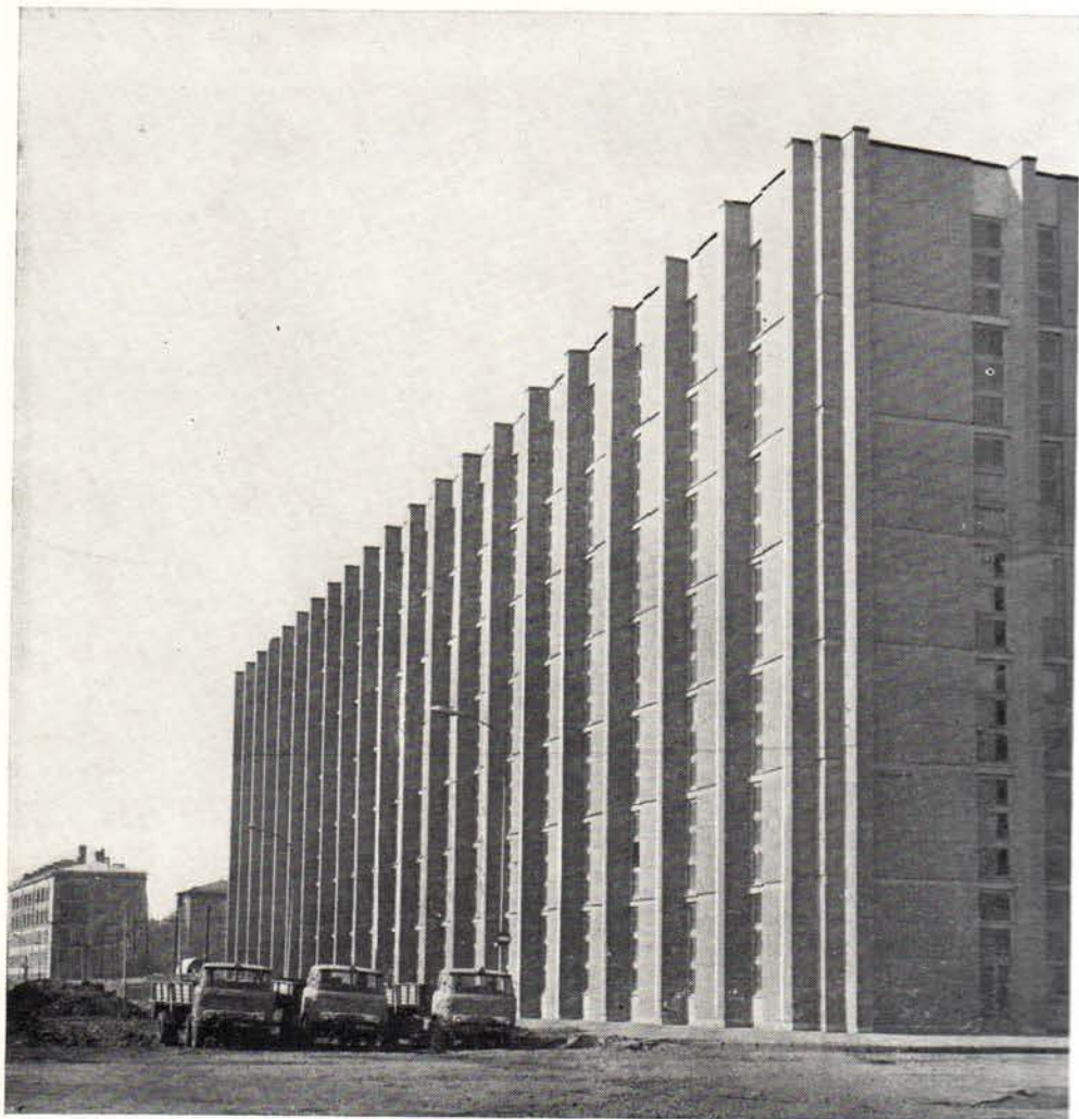
▲ Ленинградское объединение «Электросила». Корпус испытательного стенда турбогенераторов Ленинградское объединение «Электросила». Здание лаборатории головных образцов. Фрагмент ▼
