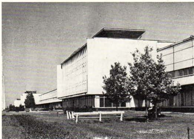
Волжский автомобильный завод. Главный корпус
