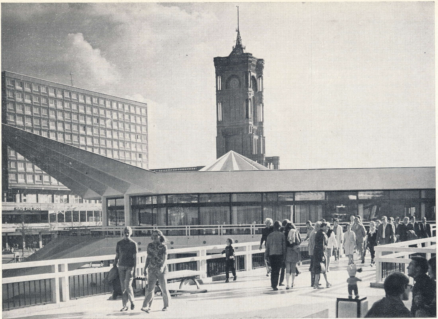
Берлин. Общественная зона у телевизионной башни. На втором плане — многофункциональный жилищно-общественный комплекс на Ратхаушштрассе и здание Красной ратуши.
