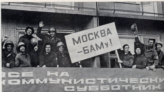
Рабочие Главмостстроя на Коммунистическом субботнике в г. Тынды
