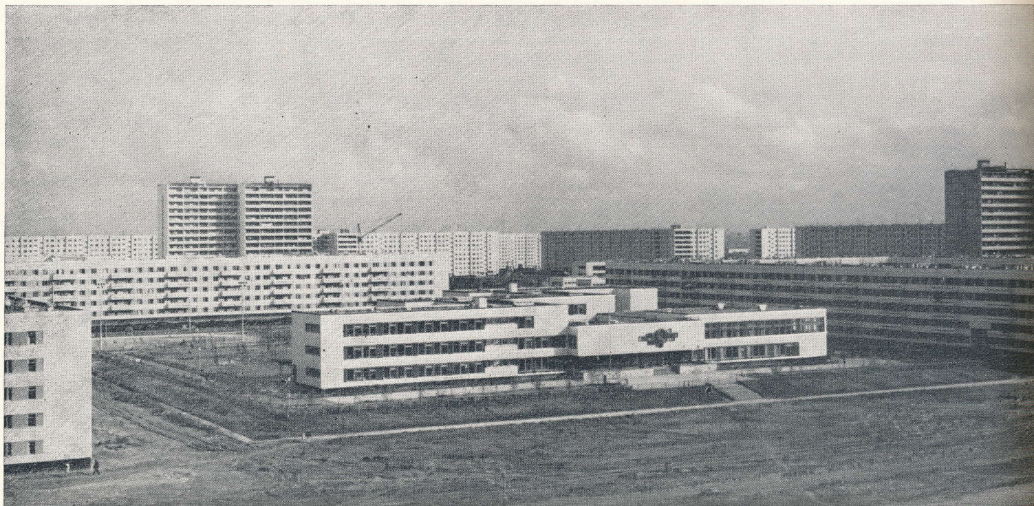
Набережные Челны. Общий вид здания школы на 40 классов в жилой застройке микрорайона
