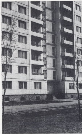
Фрагменты 9-этажных жилых домов, сооруженных на Васильевском острове
