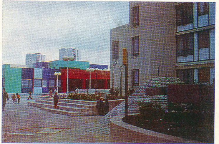
Новый Кретьей. Выделение при помощи цвета отдельных функциональных зон. Полихромный общественный центр в ахроматической застройке жилого квартала
