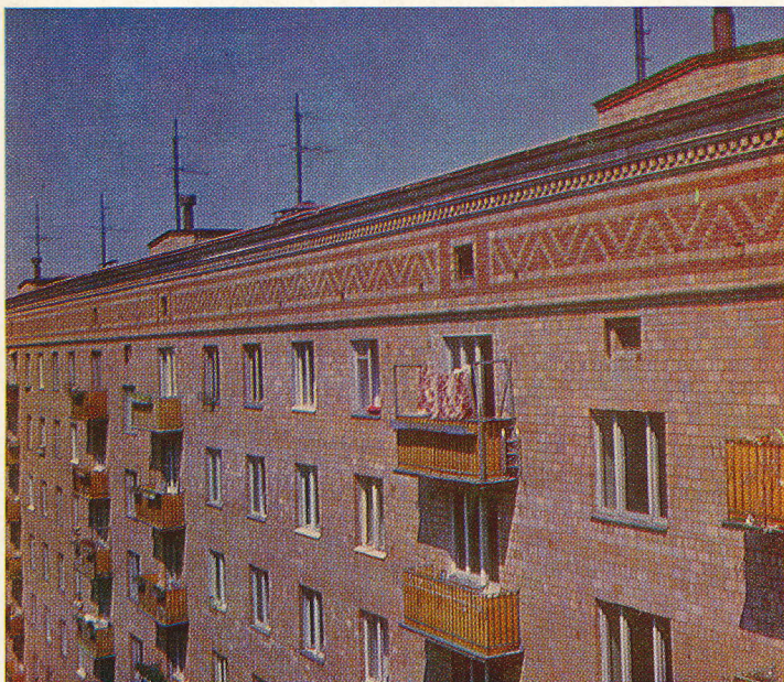
Декоративный орнамент фасада кирпичного жилого дома
