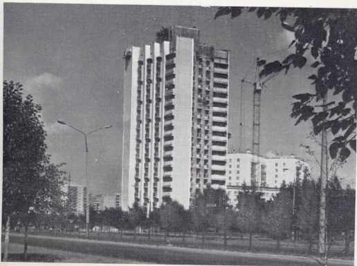
Москва. Жилой дом из монолитного железобетона, возводимый методом скользящей опалубки на Волгоградском проспекте
