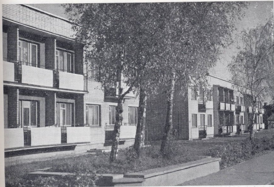
18-квартирные жилые дома в пос. Ленино
