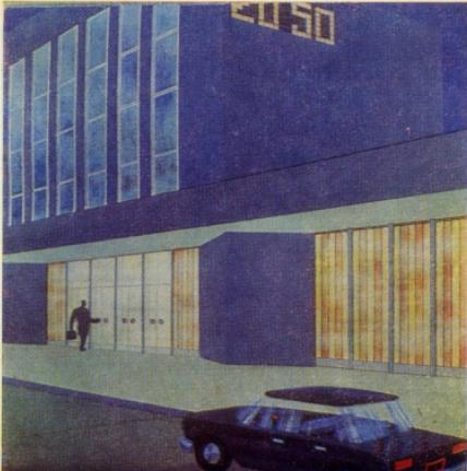
В зданиях, расположенных в южных районах, а также в средней полосе при ориентации светопропусков на юг рационально применение цветного профильного стекла холодных тонов. В объектах, сооружаемых в северных районах или в средней полосе, при ориентации светопропусков на север наиболее предпочтительно применение профильного стекла теплых тонов. Этим достигается определенная комфортность микроклимата.
