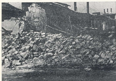
Одесса. Здания, разрушенные во время войны
