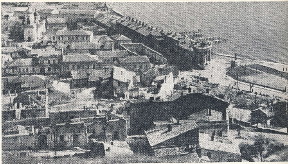
Керчь. Здания, разрушенные во время войны
