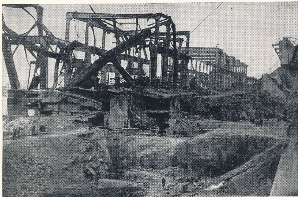
Днепрогэс, разрушенный немецкими захватчиками
